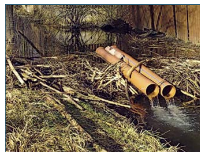
Abb. 18: Rohre im Biberdamm senken den Wasserspiegel.
