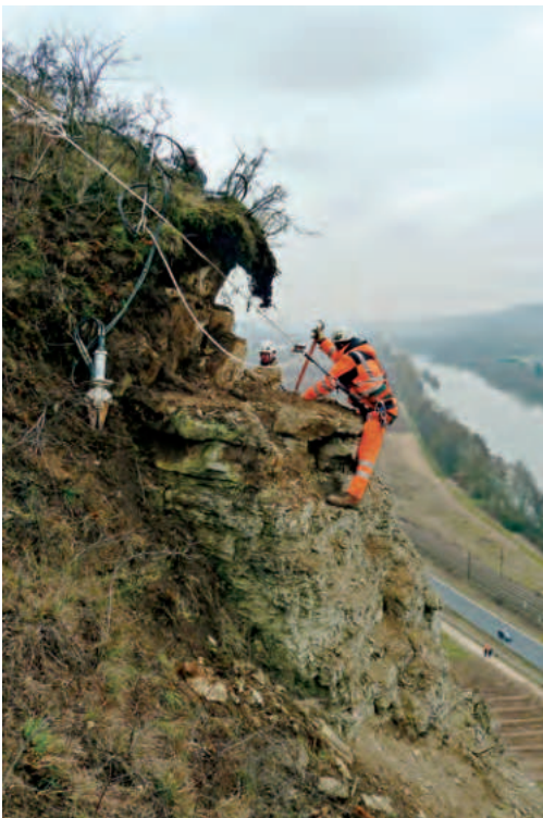
Arbeiten in circa 80 Meter Höhe an der oberen Schaumkalkbank des Retzbacher Benediktusbergs. Foto: Gutachter, 18.02.2013
