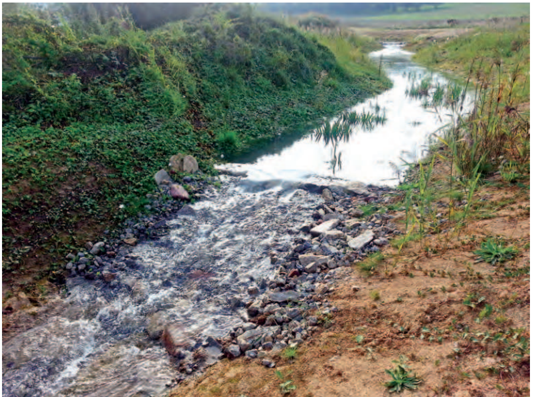
Beginn der Renaturierung 2014 mit Mäandrierung und Belebung des Gspringsbachs.
