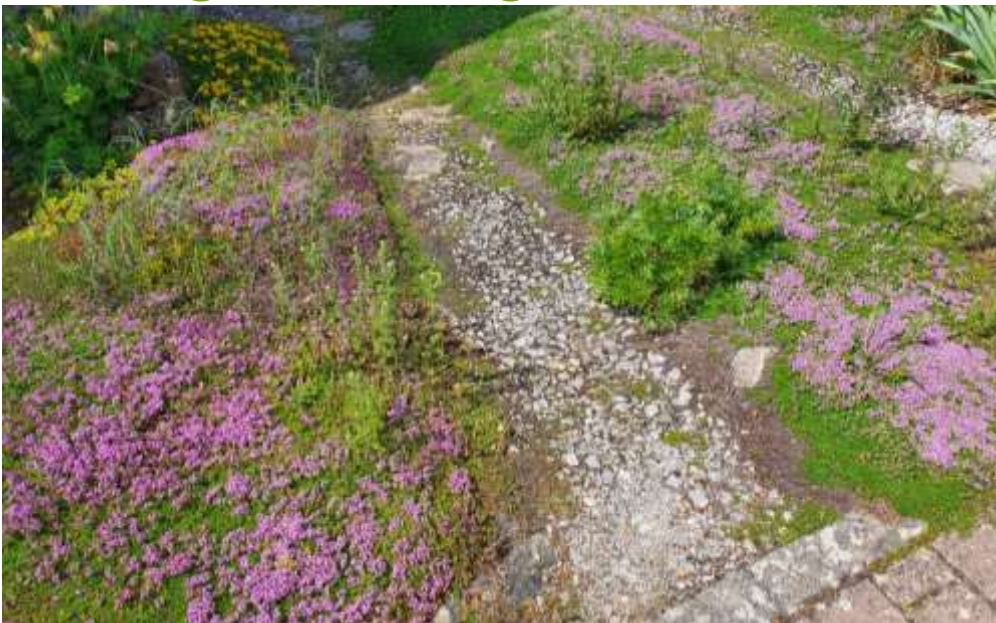
Beispiel für einen versickerungsfähigen Weg und Stellplatz, der gleichzeitig die Biodiversität fördert, Bild: Steffen Jodl
